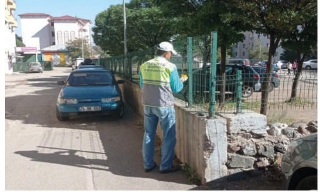
Yeni park yapım aşaması
